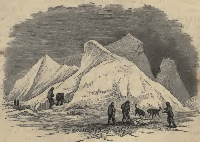
DIGGING OUT THE DEPÔT.
