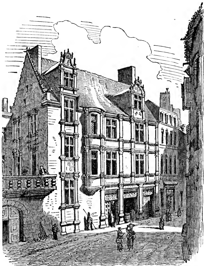
Casa no estylo do Renascimento, em Périgueux
