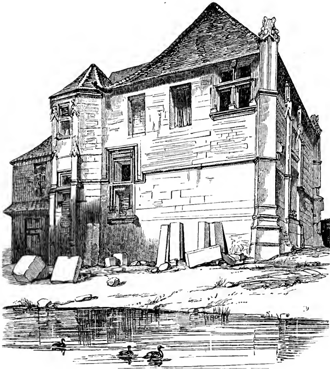
Casa de cantaria em Saint-Pierre-sur-Dive
