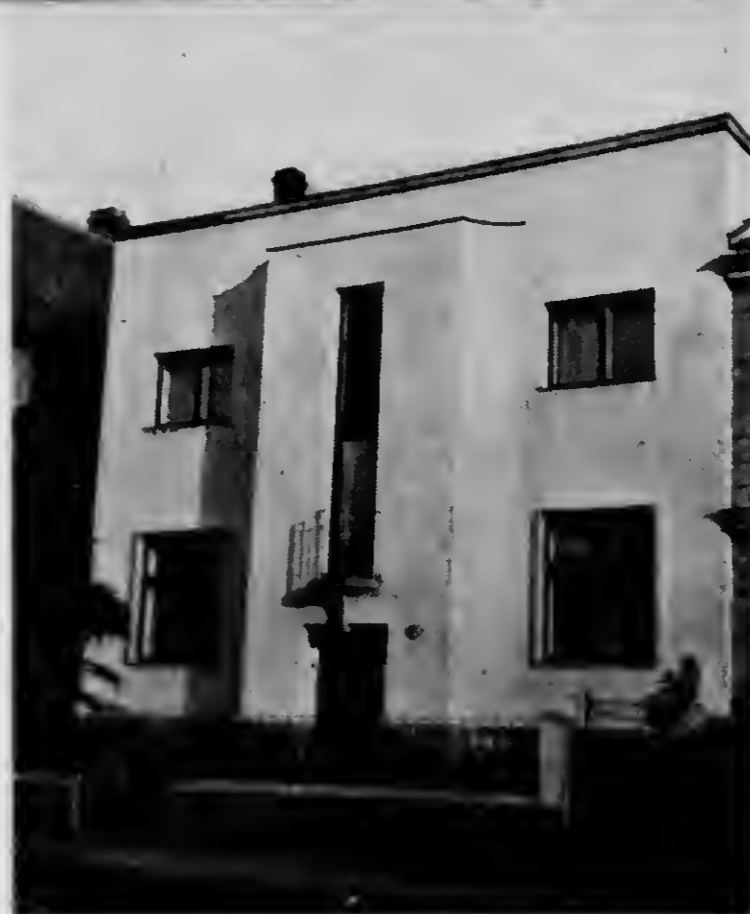
Po adaptaci Nach dem Umbau
