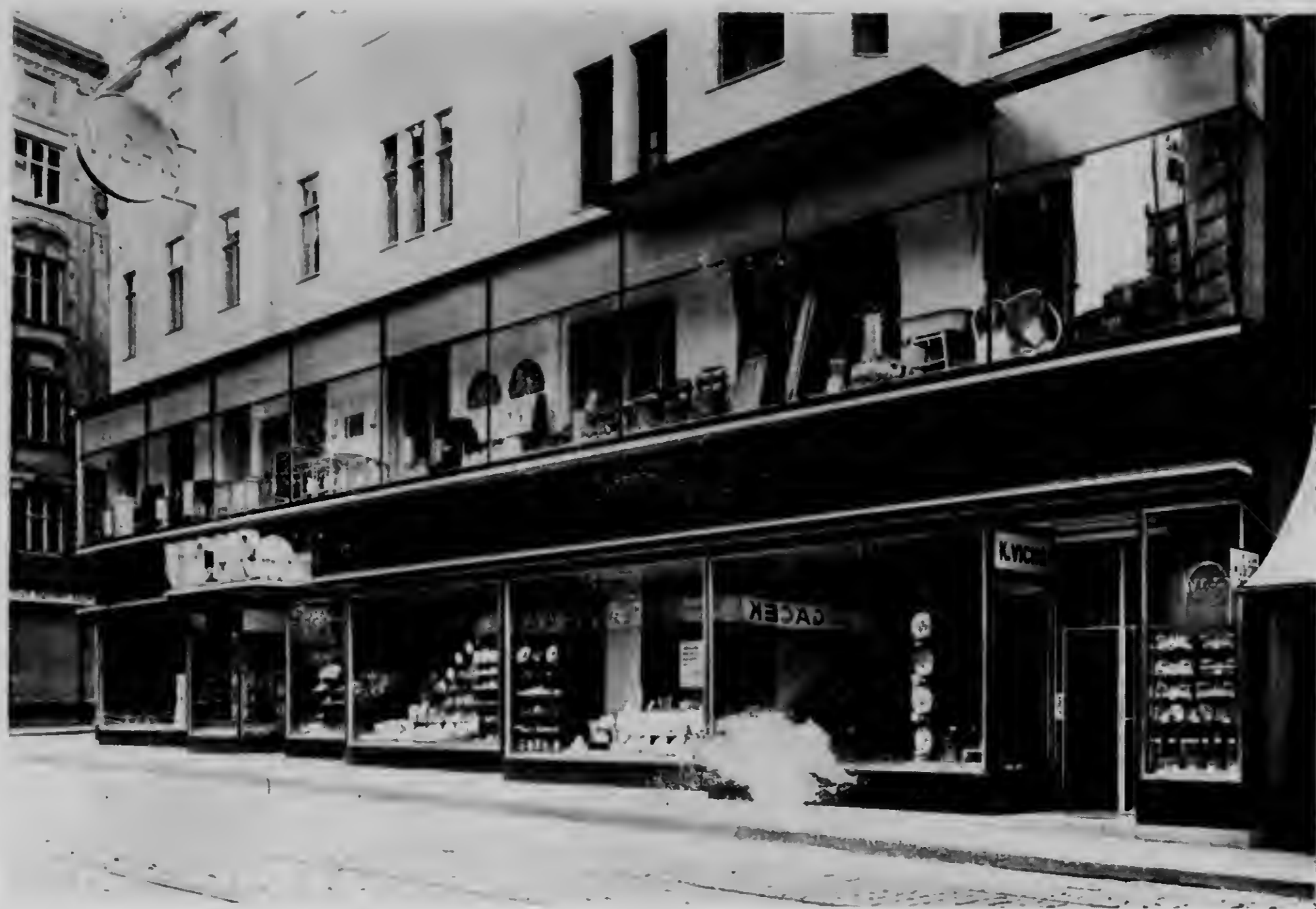
Arch. Norbert Troller Eisenkonstruktion mit Nirosta-Glashedeleisten. Sockel und Firmentafel weinrotes Opaxit. Eisenkonstruktion und vorspringende Gesimse, weinroter Dukoanstrich mit silbergrau abgesetzten Streifen. Untersicht der Gesimse und Platonds weisses Opaxit. Auslagen Innen rötliche Kirsche.
