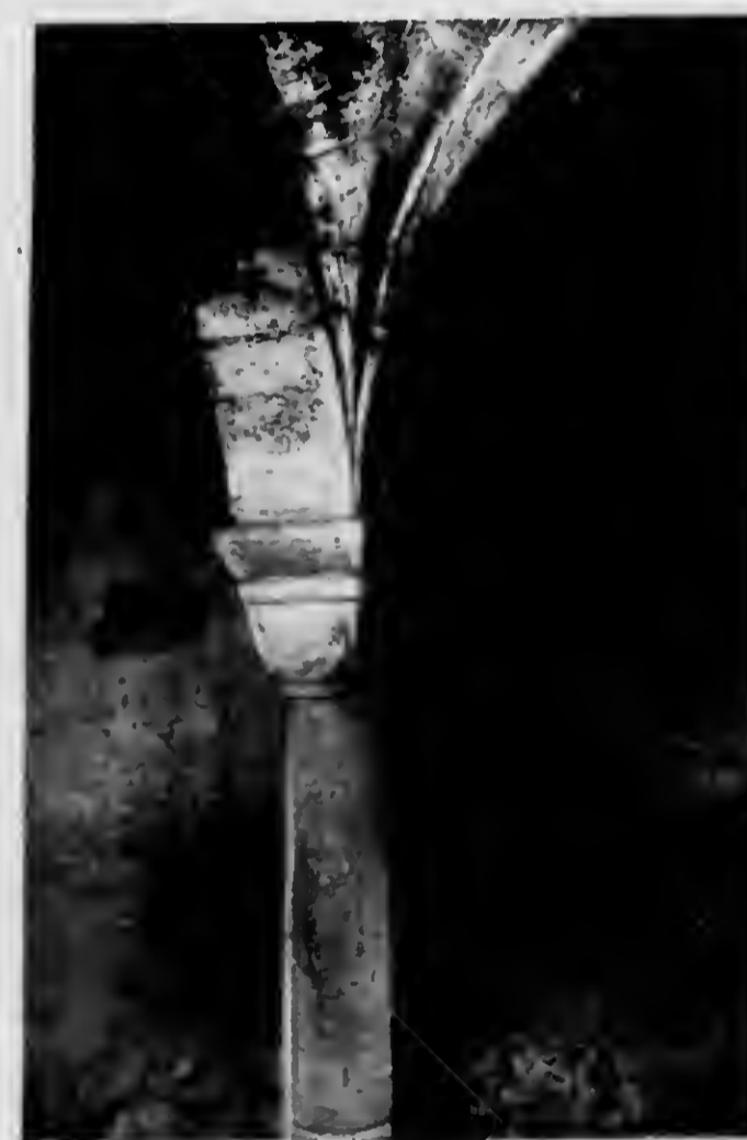
Das Kreuzgewölbe mit der romanischen Säule.
