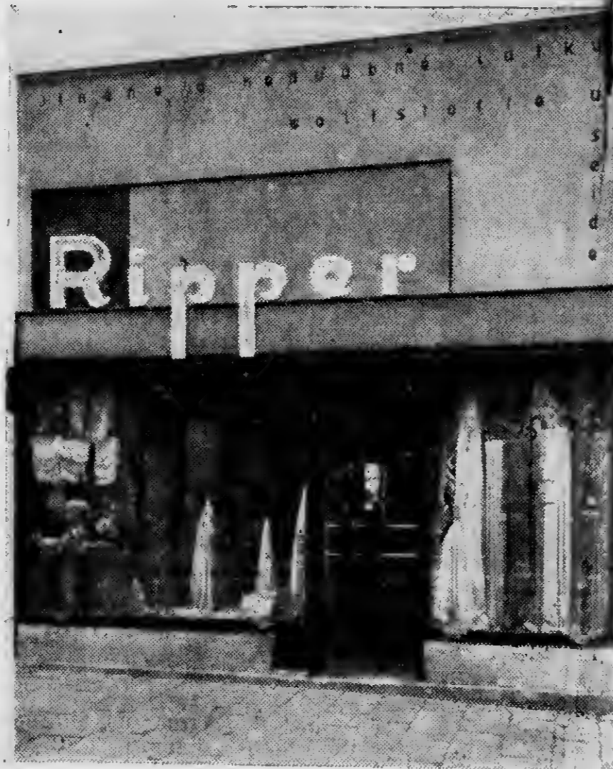
Portalumbau des Wollstoff- und Seidenhauses J. Ripper, Brünn, Kennergasse. Glasarbeiten: Brüder Fuchs, Brünn.
