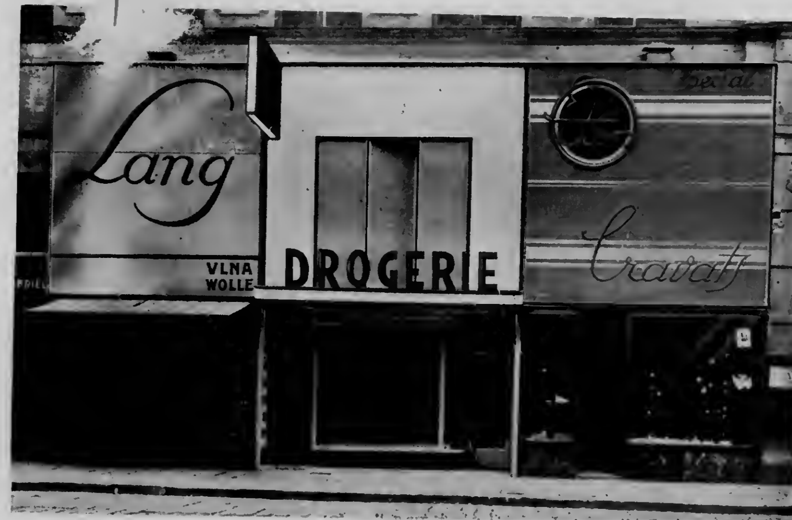
Kravattengeschäft. Eisenkonstruktion mit Bronze vollkommen verkleidet. Firmentafel Glas mit Untermaulung, Silberfolie creme, plastische Bronzeblechbuchstaben kombiniert mit Neon. Sockel dunkelgrüner Marmor. Auslagen Innen Tuja und Nuss.
