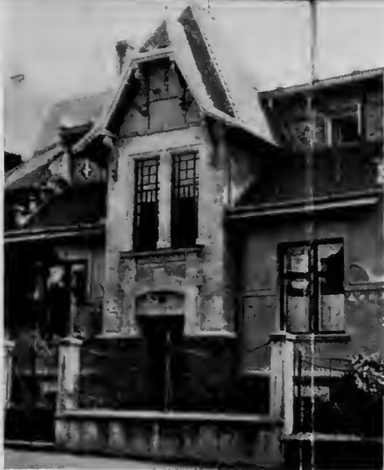
Před adaptací Vor dem Umbau
