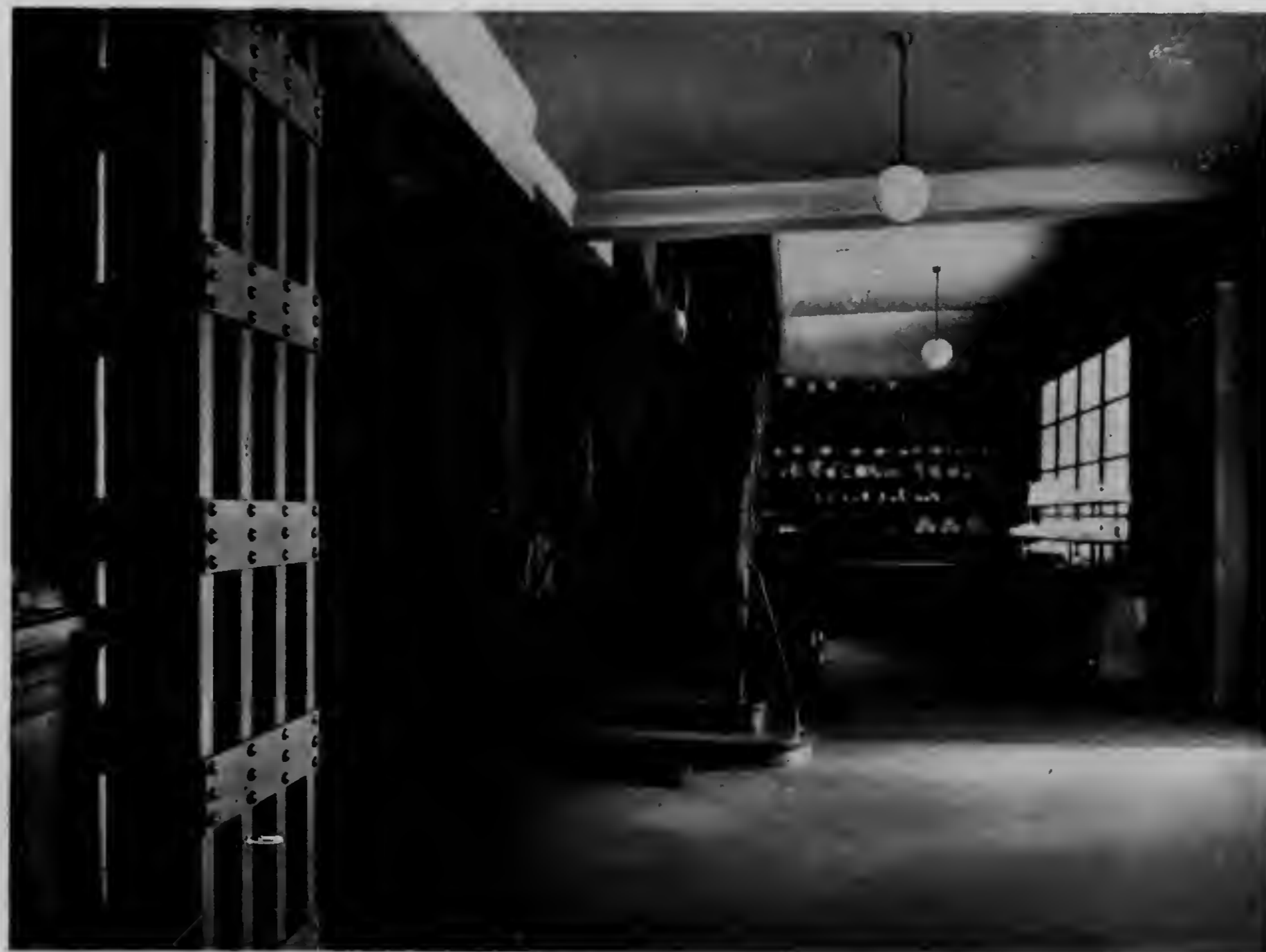
Arch. Norbert Troller Innenansicht der Eisen- und Geschirrhandlung Weltgehender innerer Umbau durch Verbindung zweier gänzlich verschiedener Häuser. Fast vollkommene Auslösung der Mittelmauer und Abfangung derselben auf wenige Säulen aus Stahl.
