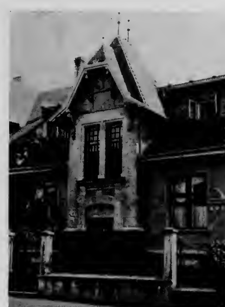
Před adaptací Vor dem Umbau
