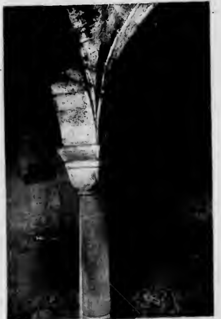
Das Kreuzgewölbe mit der romanischen Säule.
