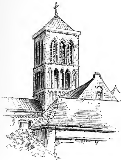
TOWER OF S. TRINITÉ, FÉCAMP.
