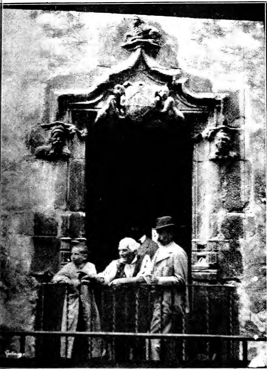
Balcón de casa Desprat.
