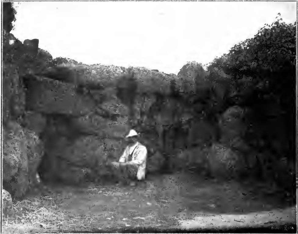
FIG. 5. — Feritoie vedute dall'interno e porta di accesso alla galleria di comunicazione alla torre E .
