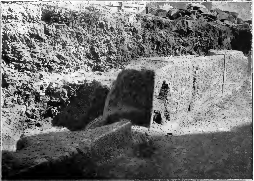
FIG. 4. — Muro a grandi blocchi scoperto a nord dell'edificio scolastico.
