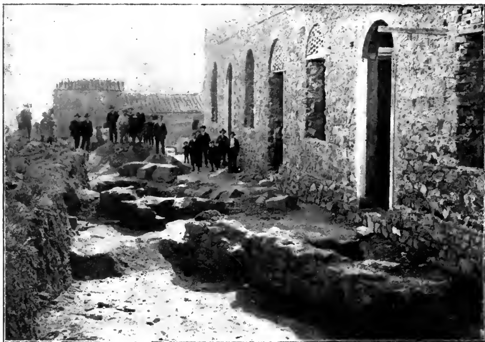
FIG. 3. — Veduta dei ruderi scoperti per la costruzione dell'edificio scolastico.
