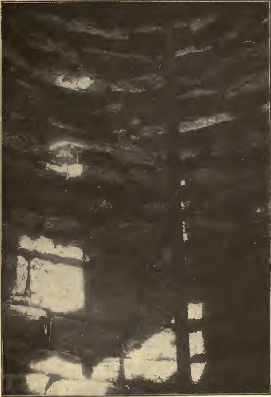
FIG. 8. — Struttura della parete della cupola che ricopre la fonte saera. Il corso di pietre di maggior spessore corrisponde alla base della cupola, formata dalla rastremazione dei corsi. (Nel centro il tubo della pompa)
