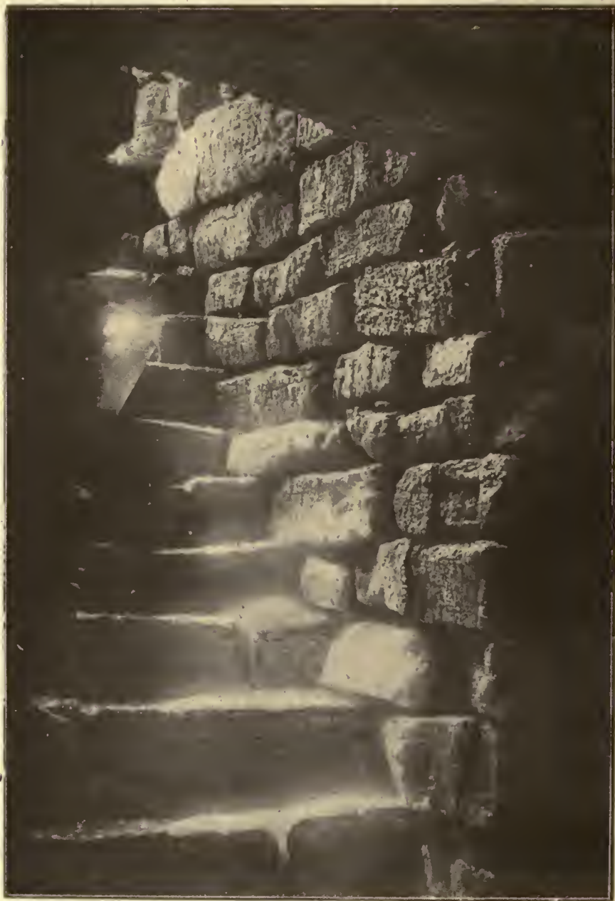
FIG. 7. — La scala che scende al pozzo.
