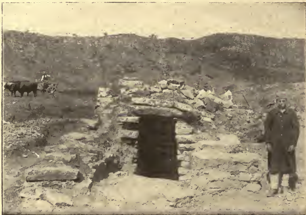
FIG. 3. — Le ali dell'atrio, col selciato innanzi alla porta d'ingresso della scala. È visibile l'inclinazione delle pareti esterne della cupola.
