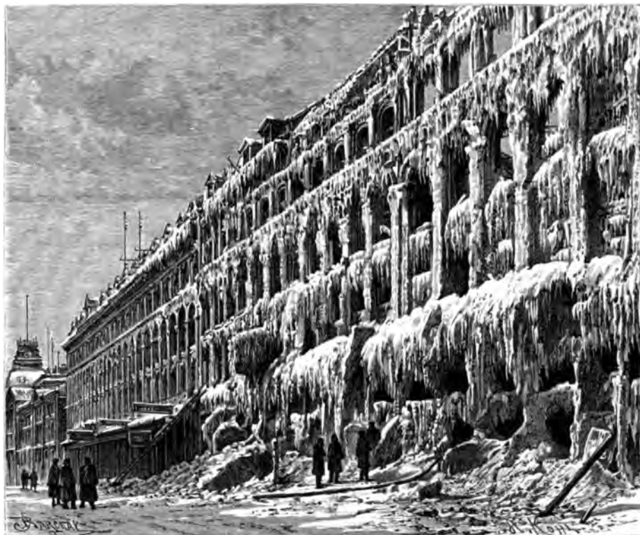
STALACTITES DE GLACE SUR LA FAÇADE D'UNE MAISON INCENDIÉE.
