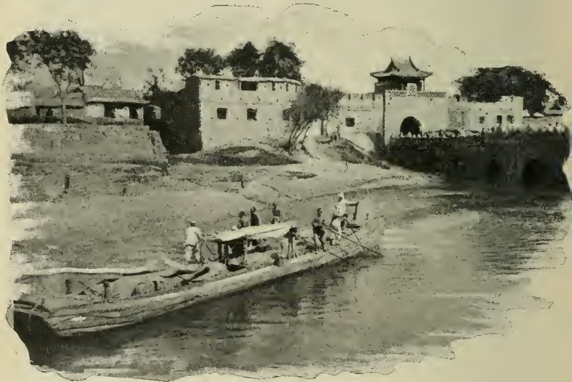
Ponte all'ingresso di Wei-hui.
