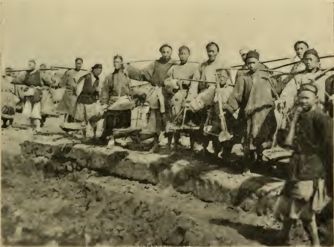
Operai terrazzieri che riparano un argine del fiume Han.
