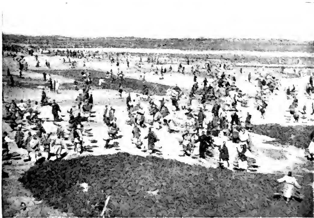
Operai addetti alla riparazione d' un argine del fiume Han.
