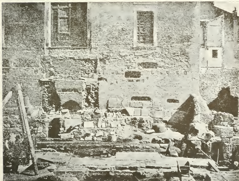
Area del Comizio e facciata della Curia, con loculi cristiani.
