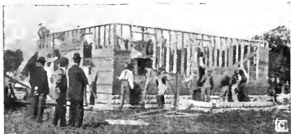
Casa in legno alla 7ª ora di lavoro.
