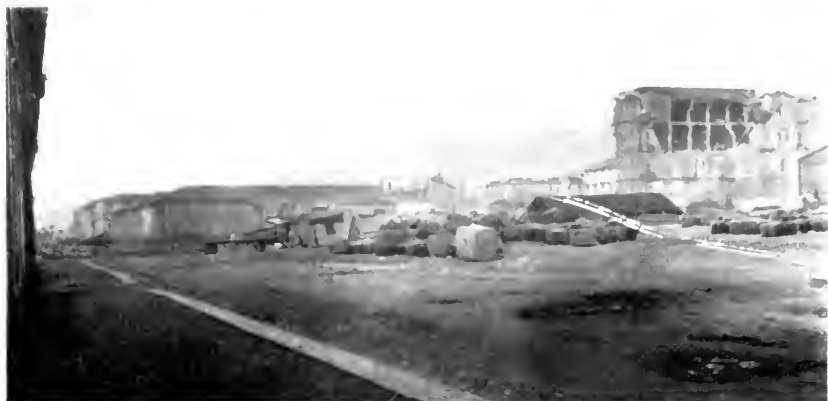
Messina - Nei pressi della stazione.
