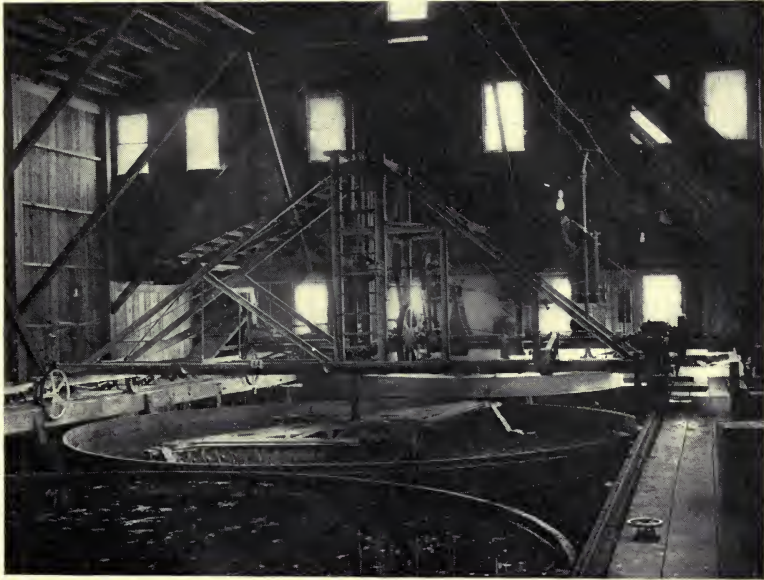
FIG. 58. BLAISDELL EXCAVATOR.
