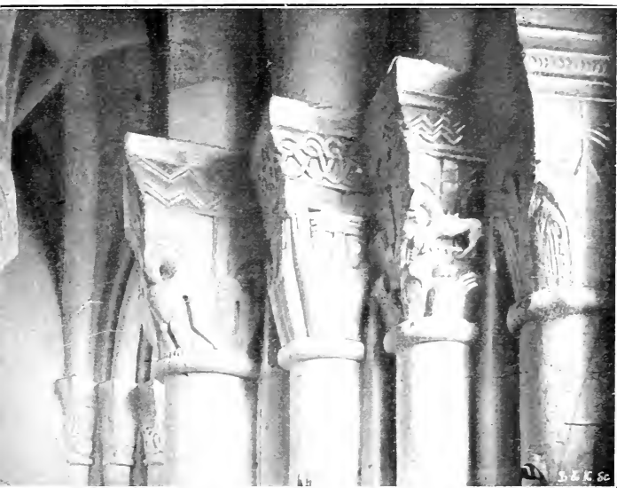
FIG. 204. — Déambulatoire de Morienvall Oise .
