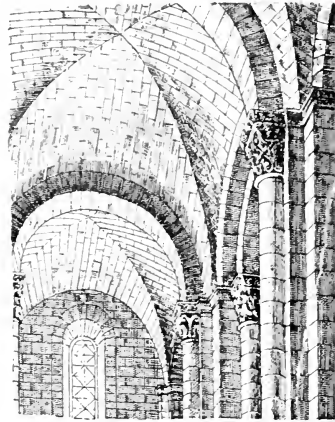
FIG. 107. — Voûtes latérales de la de Vertheuil (Gironde).
