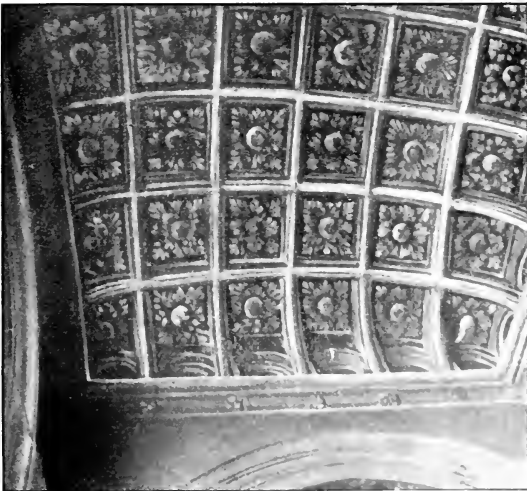
FIG. 343. — Voûte de la chapelle de la Vierge à Saint-Agricol d'Avignon 1517 .
