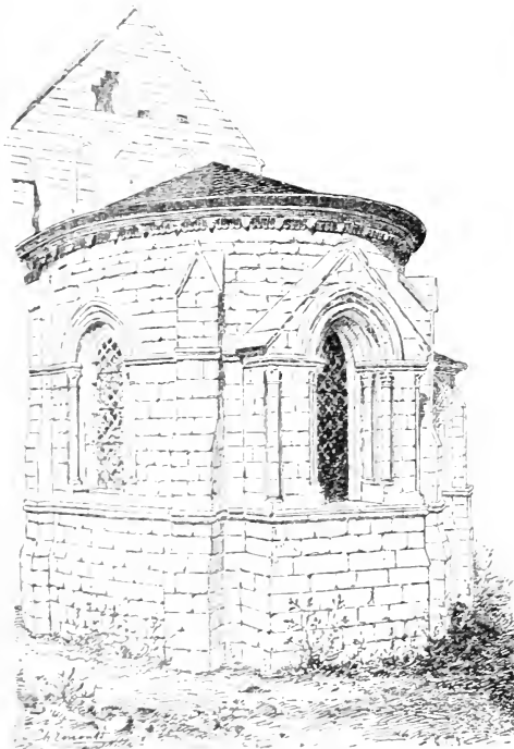
FIG. 78. — Abside de Nouvion-le-Vineux Aisne.
