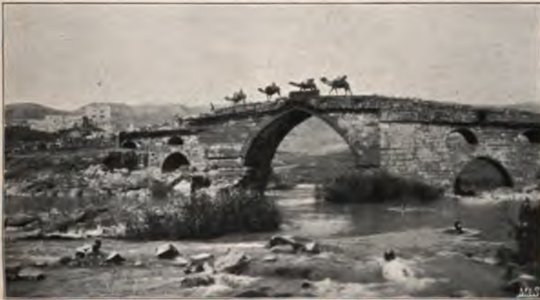
2. Jordanbrücke dschisr el-medschämi'.
