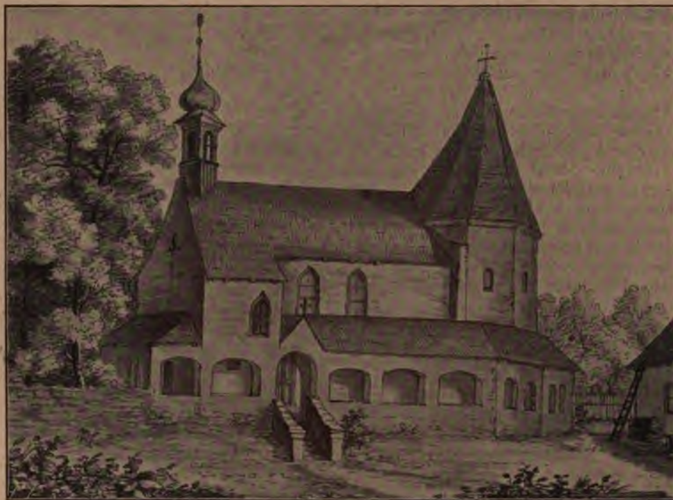
Obr. 3. Kaple v „Kajetánce“ r. 1820.
