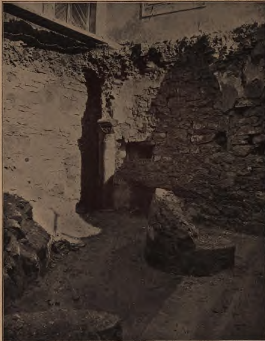
Obr. 2. Část zdiva románské krypty s polosloupem.
