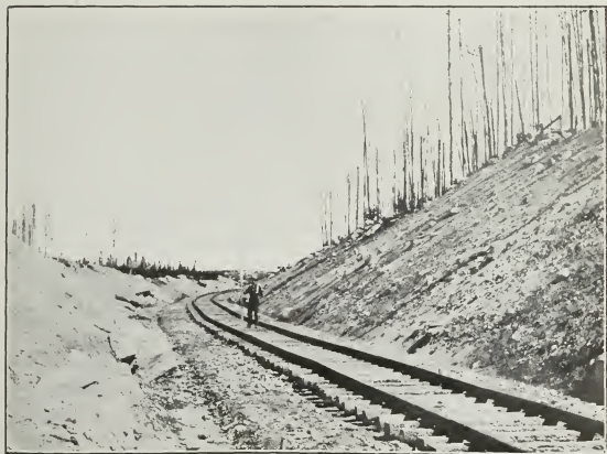
Poste 24, mille 59, vu de l'ouest. Station 3, 110, 31 août 1909.
