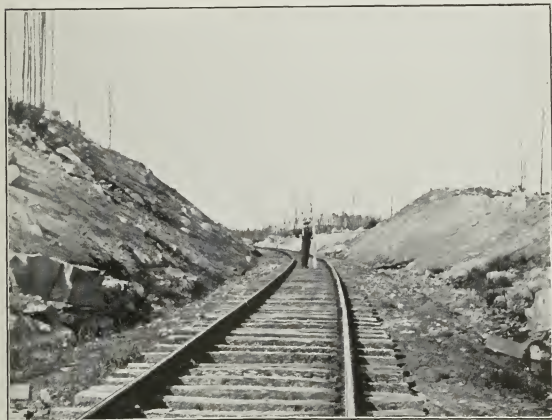
Poste 24, mille 59, vu de l'ouest. Station 3, 110, 31 août 1909.
