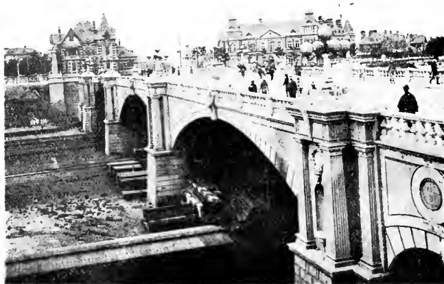
Nippon Bridge, Dairen
