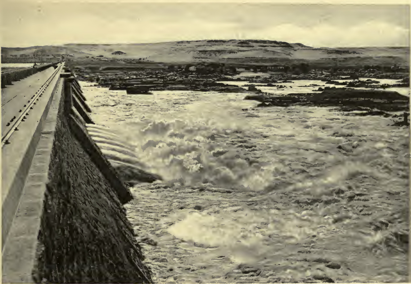
Réservoir du Nil à Assouan. The Assouan Dam.
