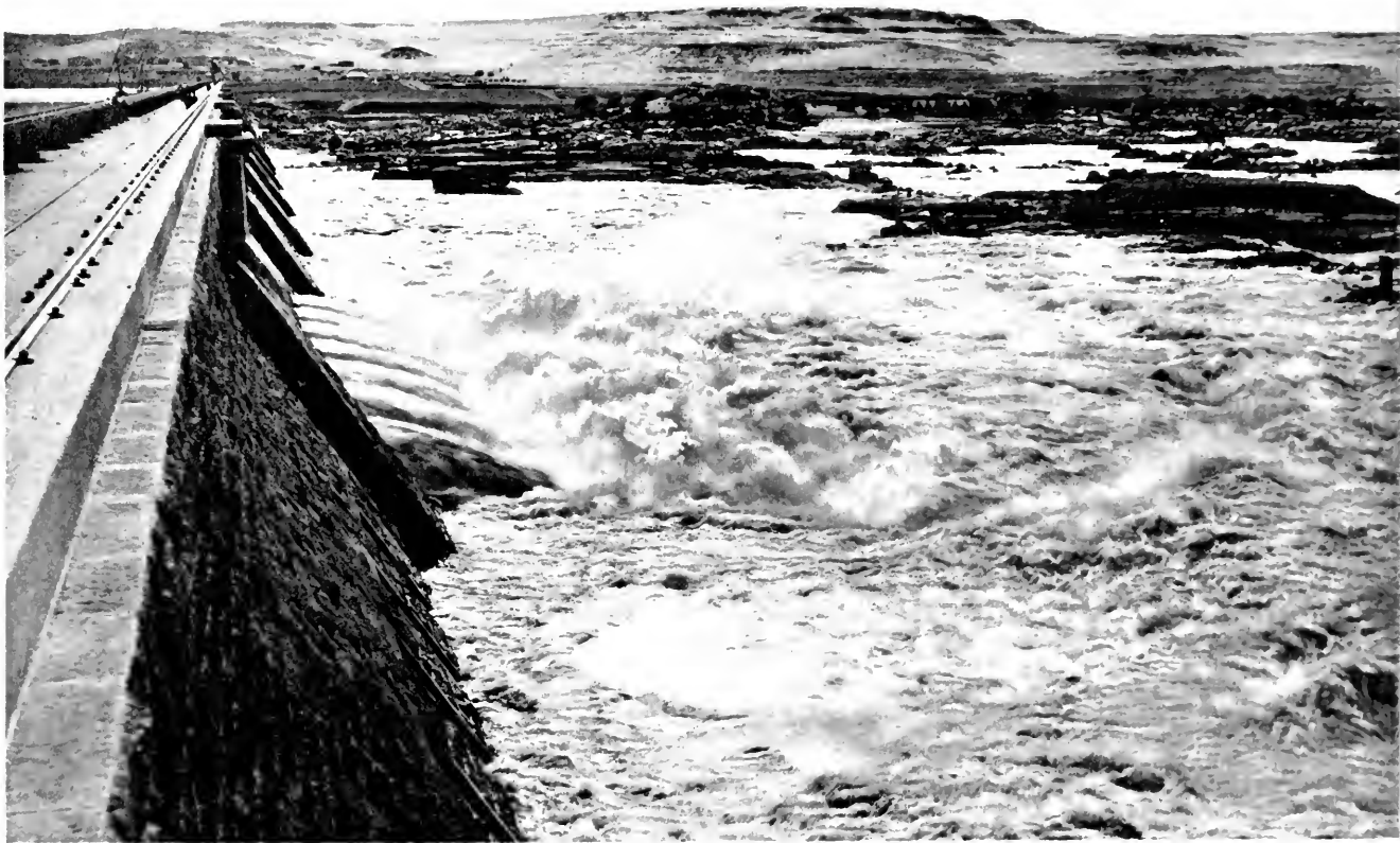
Réservoir du Nil à Assouan. The Assouan Dam.
