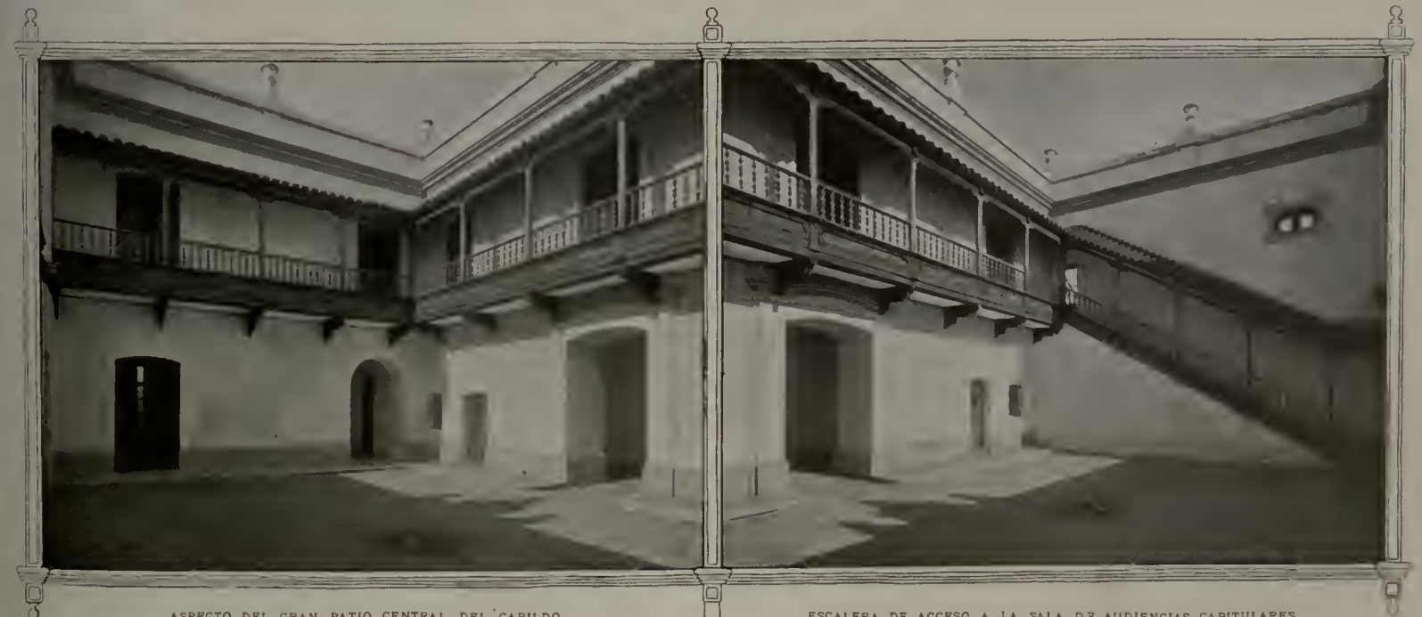
ASPECTO DEL GRAN PATIO CENTRAL DEL CABILDO.
