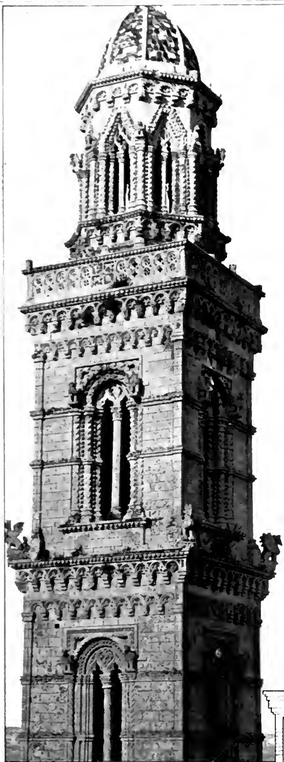
LA TORRE ALPATA DE SOLETO.
