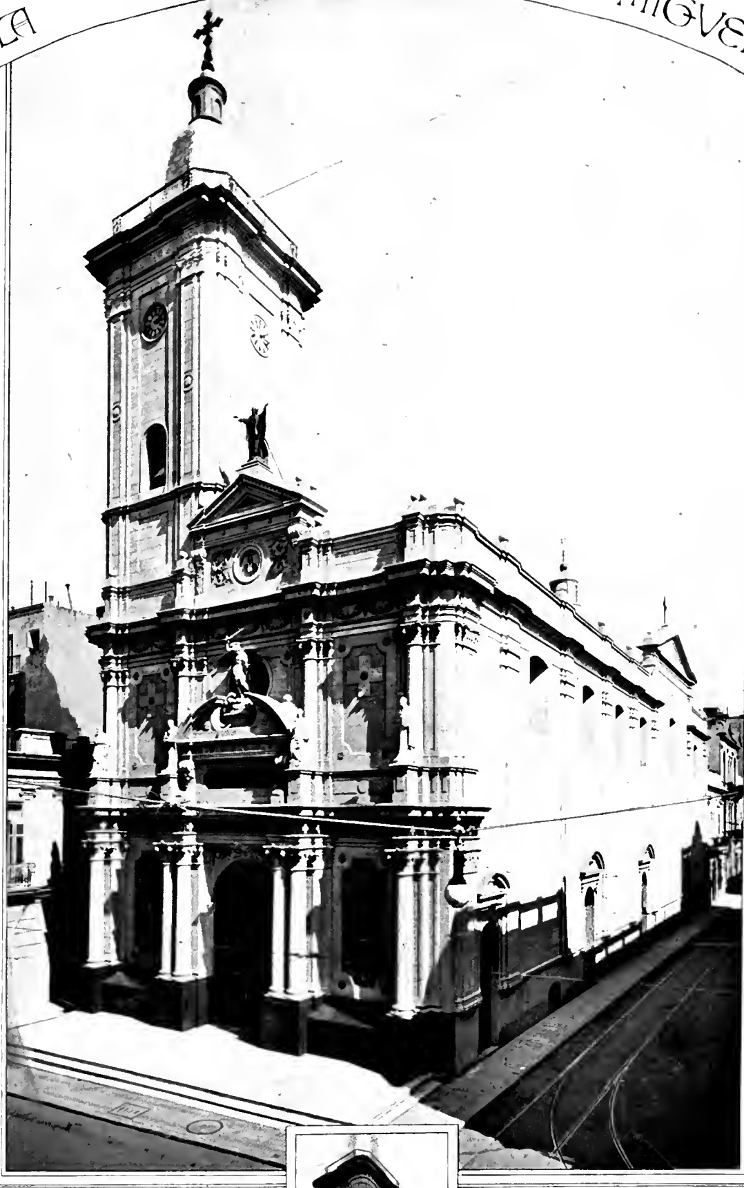
EN EL NUEVO FRENTE LA LUZ SOSLAYA LOS RELIEVES DEL EDIFICIO. PROYECTADA POR
