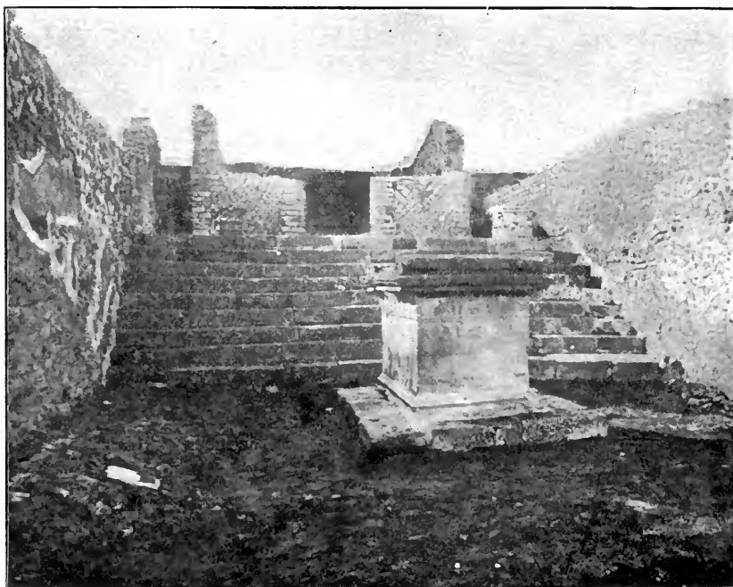
Fig. 29. Ruines. — Voir fig. 30.
