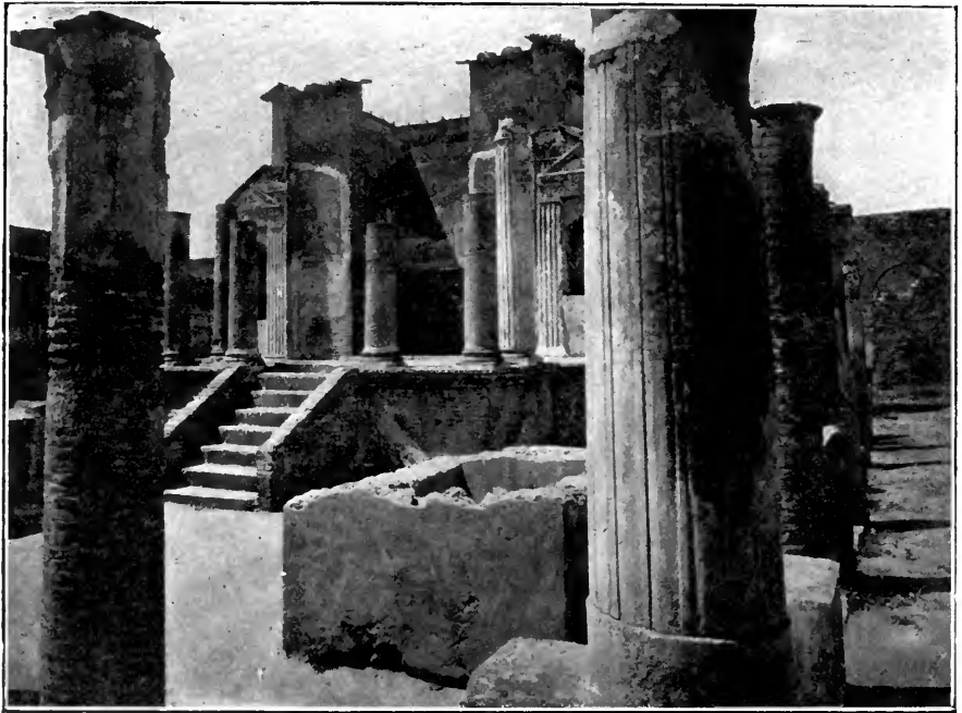
Fig. 34. Ruines. — Voir fig. 35.
