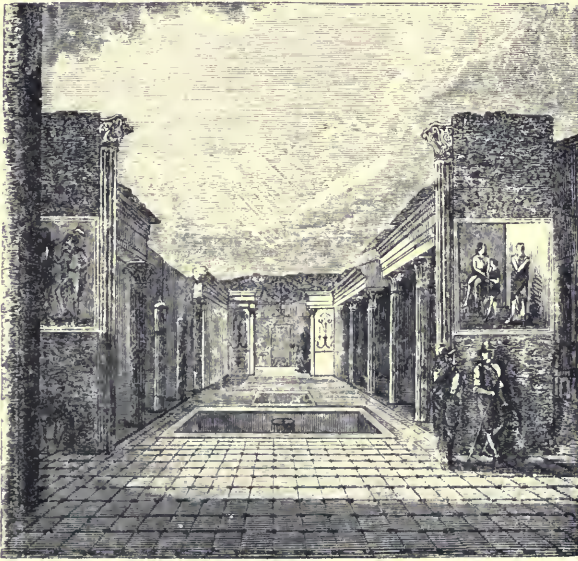
Piscine de la maison du Questeur.
