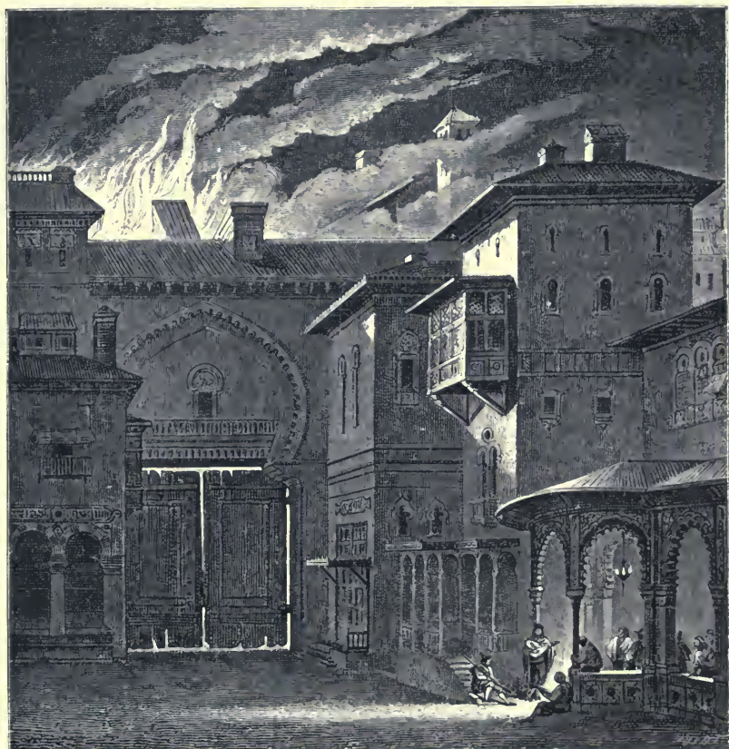
Incendie du Palais de l'Alcaiceria (Grenade).
