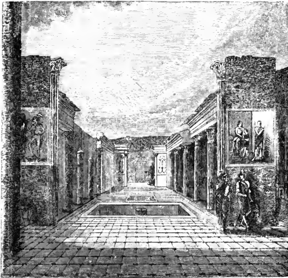
Piscine de la maison du Questeur.
