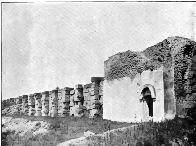
Fig. 6. — Le rempart vu du côté de la ville avec ses contreforts autrefois recouverts de terre et une tour (p. 10).
