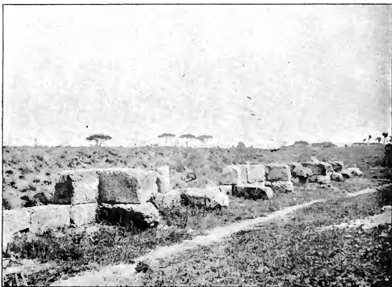
Fig. 7. — Les créneaux des remparts de Pompéi (p. 10).
