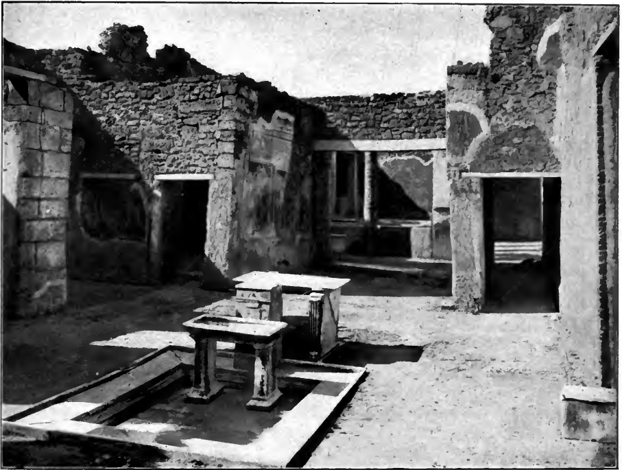
Fig. 66. — Foulerie de la rue de Stabies (p. 124).
