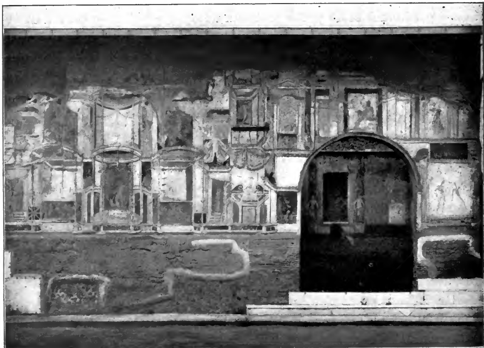
Fig. 56. — Mur de la palestra des thermes de Stabies (p. 104).
