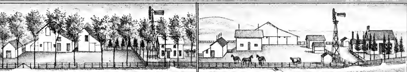
TENANT HOUSE, SEC. 11.
