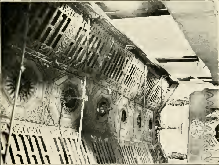
Fig. 40. CAMINHA. ROOF OF MATRIZ.
