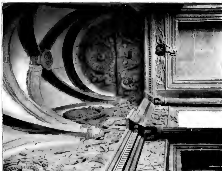
FIG. 84. THOMAR. CONVENTO DE CRISTO. SPACE IN CANTO DOS FILIZES.
