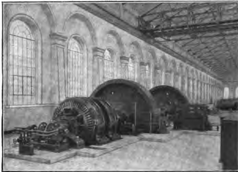
Schwungradumformer der Förderanlage der Zeche de Wendel, Pelkum bei Hamm i. W.
