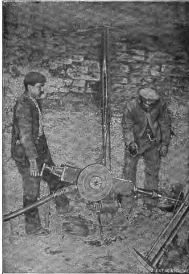
Stoßbohrmaschine (Siemens) im Betriebe.
