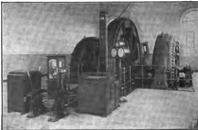
Hauptschachtförderanlage der Zeche de Wendel, Pelkum bei Hamm i. W.
