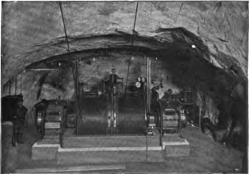
Unterirdische Sekundärstation der elektr. angetriebenen Fördermaschine der A.-G. Thiederhall.
