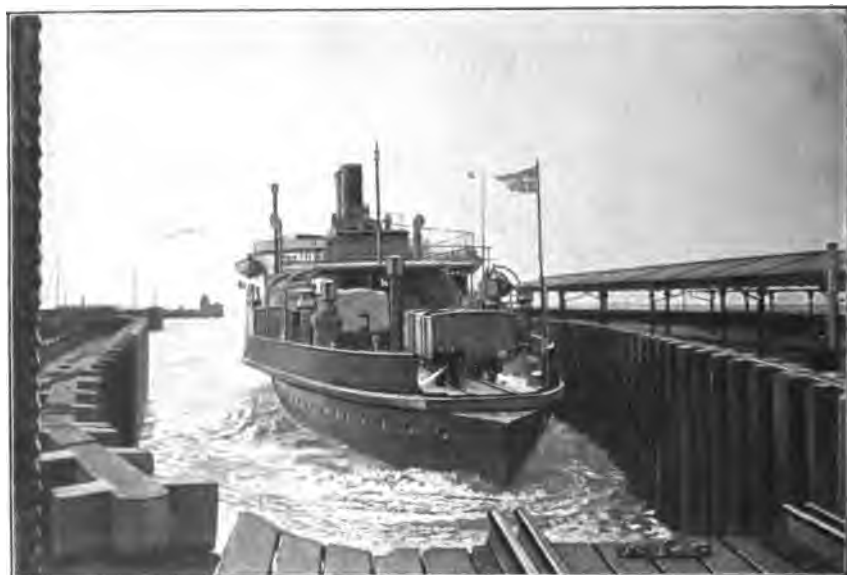
Trajektdampfer „Prinz Christian“ der Linie Warnemünde — Gledier (Berlin—Kopenhagen). Eisenbahnfähren (Trajekttschiffe) dienen hauptsächlich zur Überführung von Eisenbahnzügen über Gewässer, deren Überbrückung, sei es wegen zu hoher Baukosten, wegen Behinderung der Schifffahrt oder aus strategischen Gründen, unmöglich ist.
