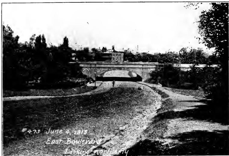
FIG. 20—EAST BOULEVARD BRIDGE.
