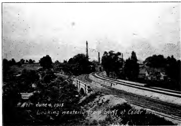
FIG. 19—EAST BOULEVARD BRIDGE.
