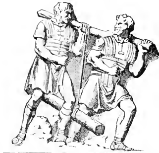
Fig. 643. — Transport des poutres.
