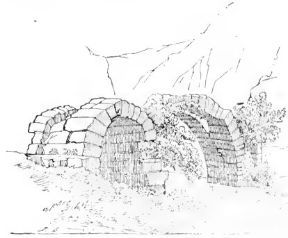
Fig. 3748. — Pont de Bieda.
