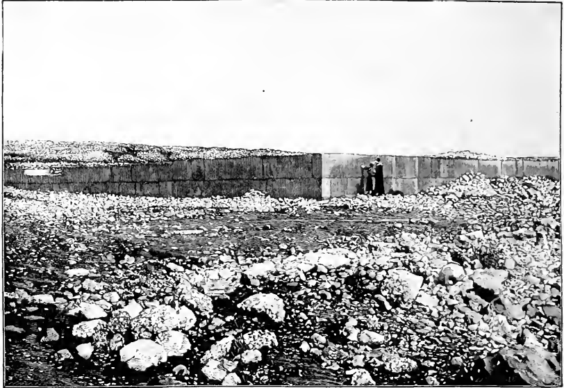
131. — Le Haram Rîmet el-Khalîl , près d'Hébron. Angle sud-ouest extérieur. A gauche, l'entrée. D'après une photographie de M. L. Heidet.
