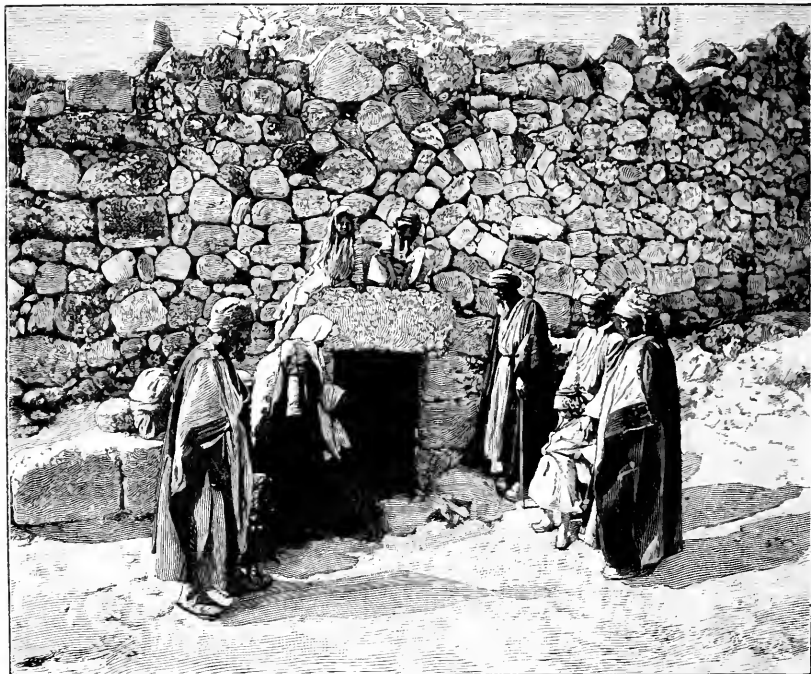
43. — Tombeau de Lazare à Béthanie. Extérieur et porte d'entrée. D'après une photographie.
