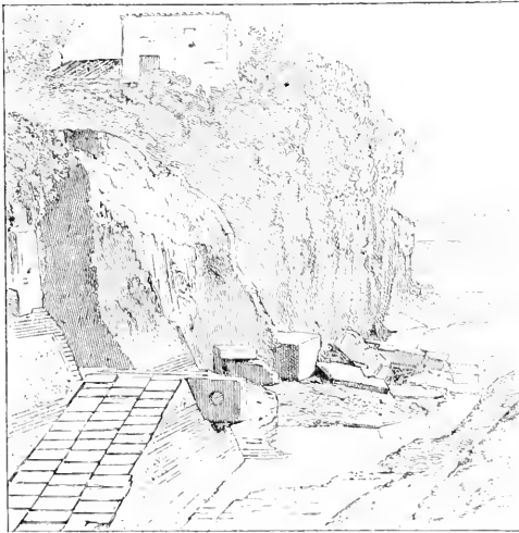
Fig. 1831. — Emporium des marbres à Rome.
