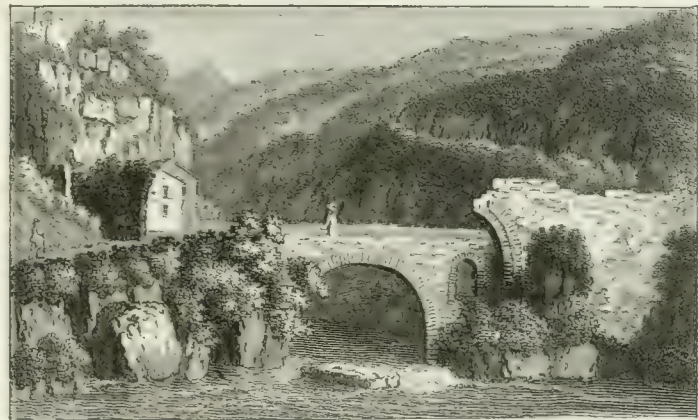
Da Franzetti Acquedotti, e Ponte di Claudio a Vicovaro
