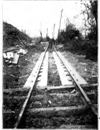
LONGITUDINAL CONCRETE STRINGERS.
