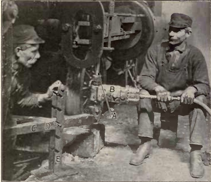
Fig. 277—Reaming Guide Bolt Holes.
