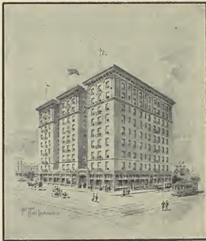
THE HOTEL LANKERSHIM, LOS ANGELES.
