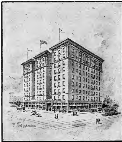
THE HOTEL LANKERSHIM, LOS ANGELES.
