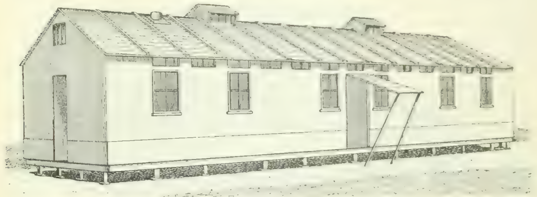
Zerlegbare Lazarettbaracke (verbessertes Döckersches Muster).
