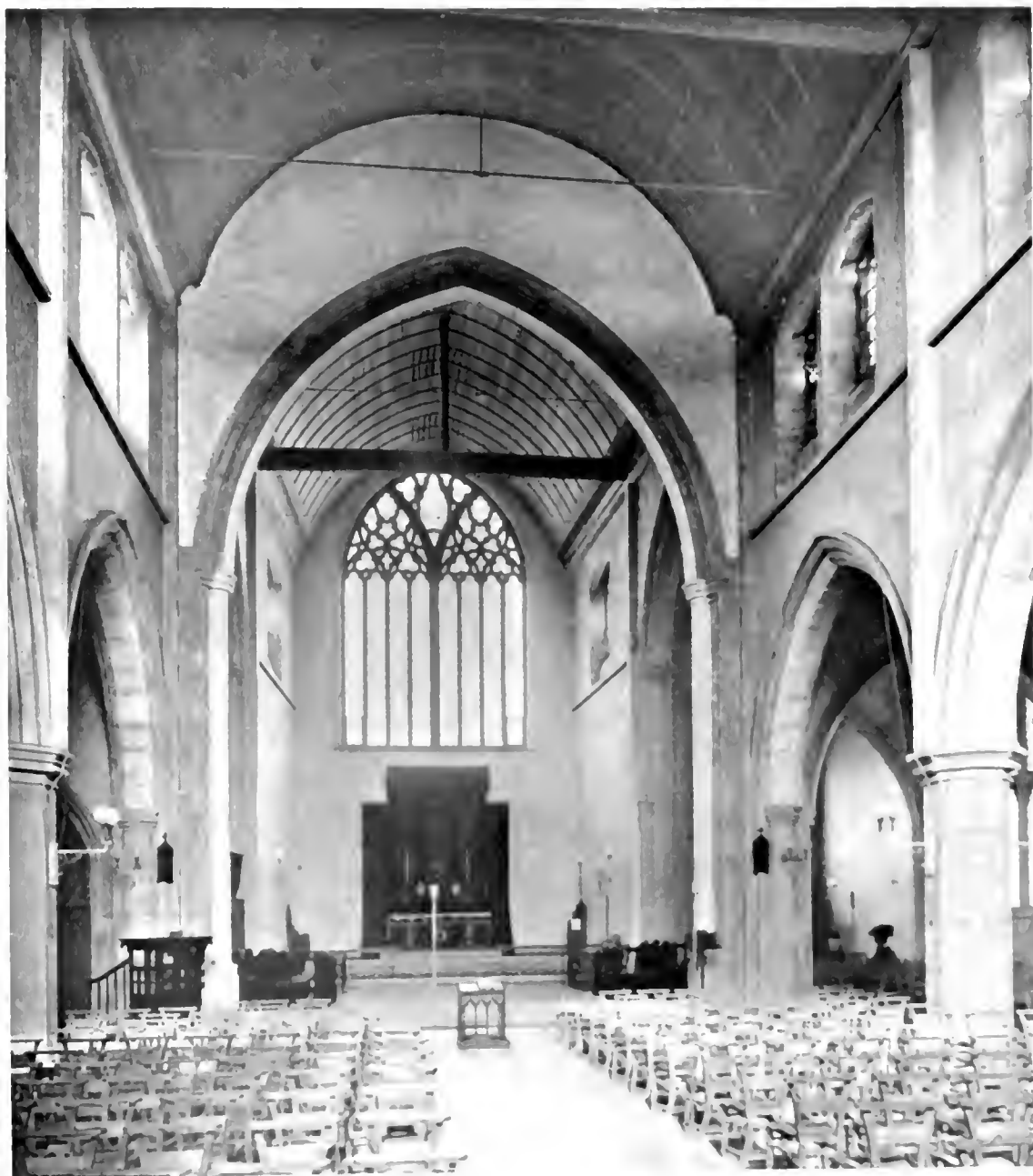
INTERIOR. LOOK N. E. W.
