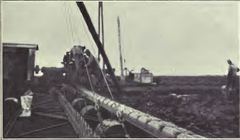
FIG. 61.—Strengre conveyor.
