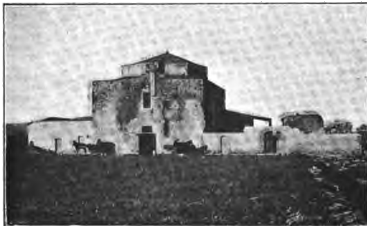
Ruinas de Centcellas (Thermae de Adriano).—Tarragona.—Vista anterior.
