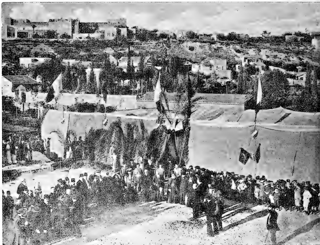
Colocación de la primera piedra de los nuevos edificios de la Facultad de Medicina de Beirut (Siria).
