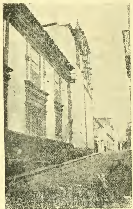
Convento de St.º André — fachada lateral, entrada para o recolhimento
