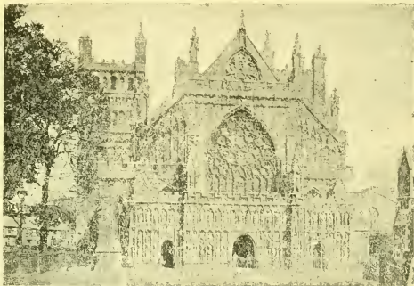
Figura 2—Exterior da Cathedral de Exeter
