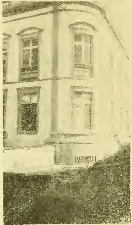
Pavilhão da Junta aonde está installado o Laboratorio
