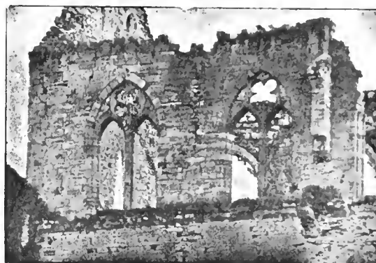
Fig. 2. Fenêtres primitives. Face Ouest du croisillon Nord du transept.
