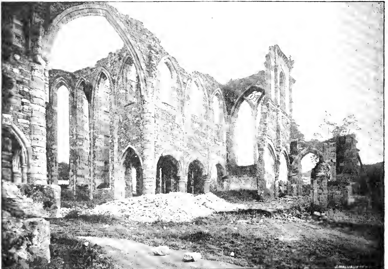
Fig. 1. — Ruines de l'abbatiale d'Aulne. — Le chœur et le transept Sud (État avant les travaux.)
