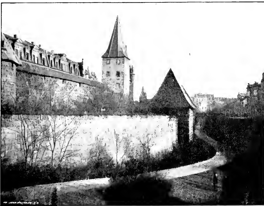
La double enceinte de murs et tonnelles sur le Frauenthorgraben.
