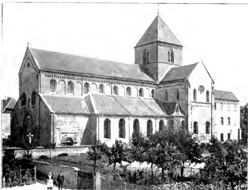
Église abbatiale Schwarzach. Vue d'ensemble.
